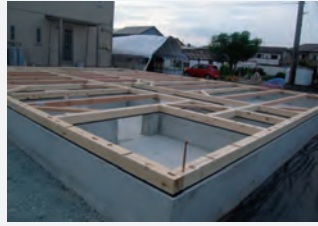
躯体構造(土台・大引)
