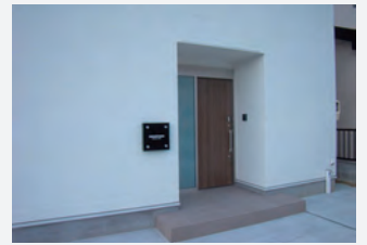
外装(玄関ポーチ+サイディング張り)
