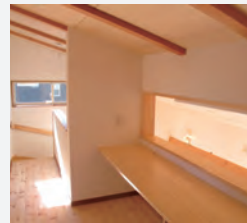
内装(無垢フローリング+壁クロス+天井合板)
