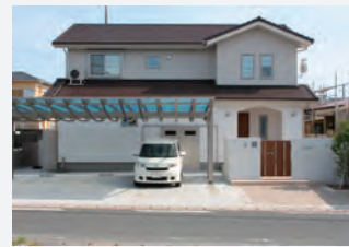
外装(瓦屋根+サイディング張り+塗壁仕上)
