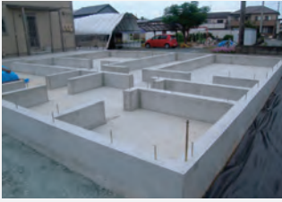
躯体構造(基礎)
