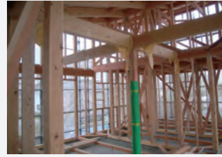
躯体構造(柱・梁桁)
