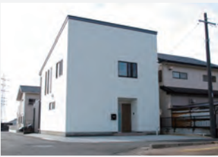
外装(ガルバリウム鋼板屋根+サイディング張り)
